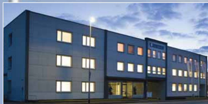
Werk 3 Standort Renzing / Plant 3 Renzing
